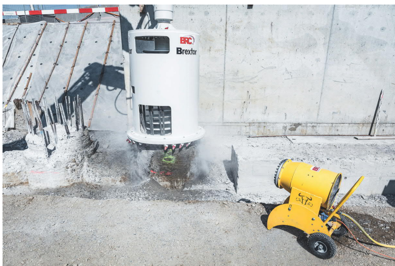
Nordumfahrung Zürich, 16. August 2018: Die Brextor-Pfahlkopffräse im Einsatz.
