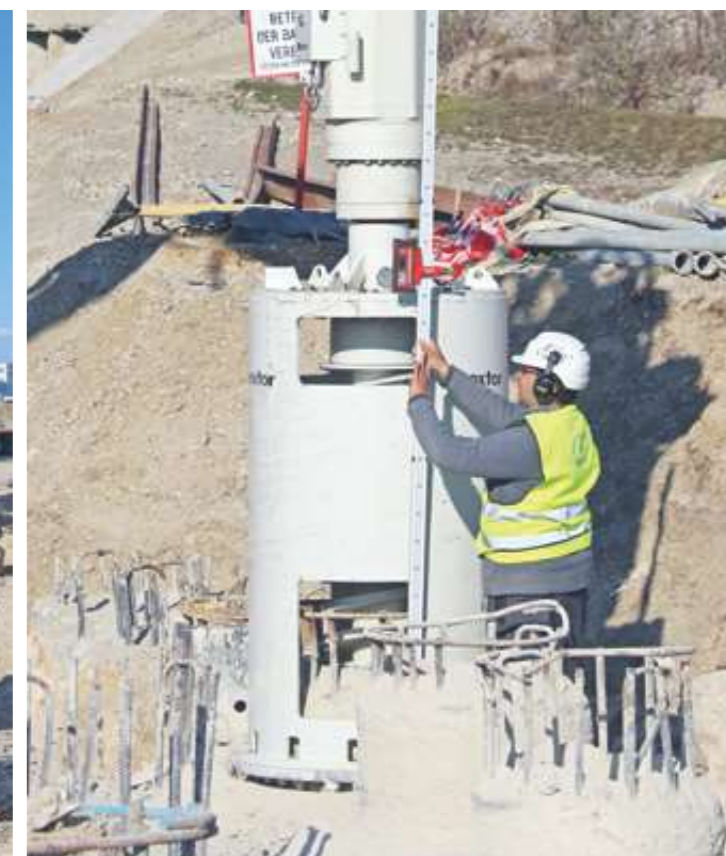
Die Pfahlkopffräse BRC Brexton fräst in wenigen Minuten die Basis für eine optimale Verbindung der Pfähle mit der Bodenplatte oder einem Betonriegel. Die Messungen bestätigen die exakte Ausführung.
