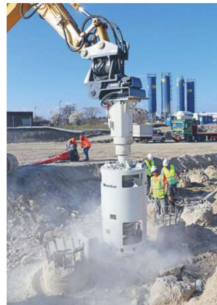
Die Pfahlkopffräse BRC Brexton fräst in wenigen Minuten die Basis für eine optimale Verbindung der Pfähle mit der Bodenplatte oder einem Betonriegel. Die Messungen bestätigen die exakte Ausführung.
