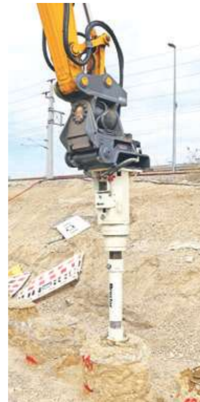
Für das Anfräsen bzw. nachträgliche säubern des Pfahlkopfes kommt eine kleine Frässcheibe zum Einsatz.
