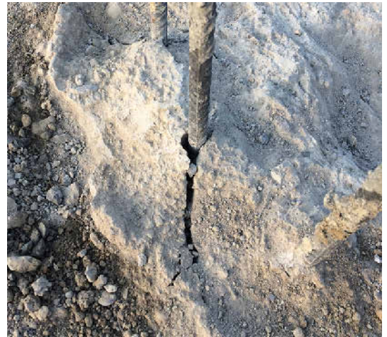
Bild 1. Bei der Bohrpfahlbearbeitung mit Luft- oder Hydraulikhämmern (links) besteht die Gefahr, dass sich Risse im Betonkörper bilden (rechts). Grafik/Foto: BRC Engineering
